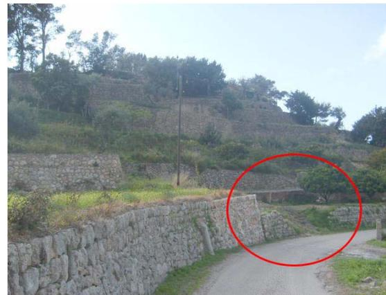
Margenes en mal estado situados aguas abajo del torrente de s'Ull de s'Aigó
